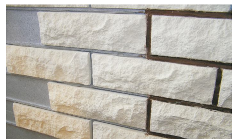
Auf der Wärmedämmplatte einschließlich Fuge montierter Klinker
