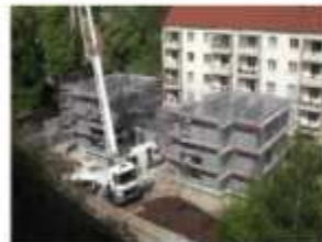
Neopor Steine werden mit Beton verfüllt.
