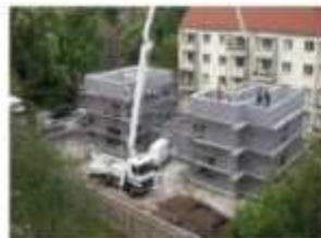
Dachgeschoß wird gesteckt und betoniert.
