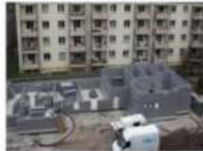
Erdgeschoß wird gesteckt.
