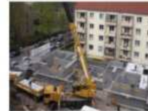
Fertigdecke wird verlegt.
