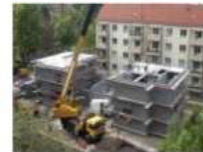
Fertigdecke wird verlegt.
