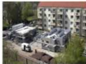
Obergeschoß wird gesteckt.
