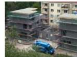
Fenster werden montiert. Elektrik und Sanitärinstallation.
