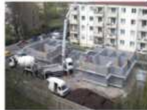
Neopor Steine werden mit Beton verfüllt.
