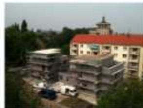
Dachstuhl wird montiert.
