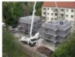
Dachgeschoß wird gesteckt und betoniert.
