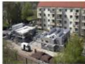
Obergeschoß wird gesteckt.
