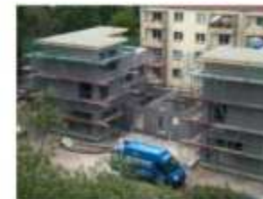
Fenster werden montiert. Elektrik und Sanitärinstallation.
