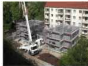
Neopor Steine werden mit Beton verfüllt.
