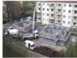
Neopor Steine werden mit Beton verfüllt.
