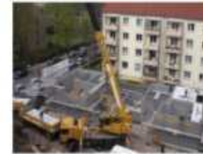
Fertigdecke wird verlegt.
