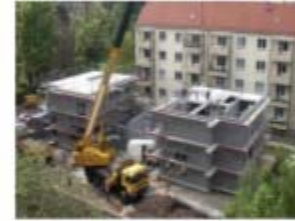
Fertigdecke wird verlegt.
