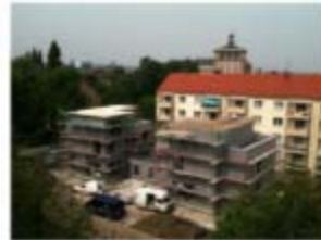
Dachstuhl wird montiert.
