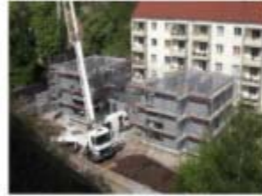
Neopor Steine werden mit Beton verfüllt.
