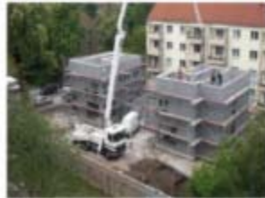
Dachgeschoß wird gesteckt und betoniert.
