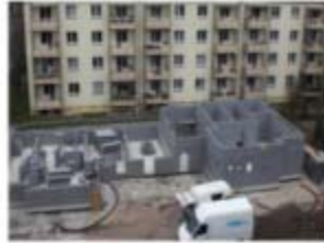
Erdgeschoß wird gesteckt.
