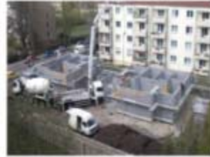
Neopor Steine werden mit Beton verfüllt.
