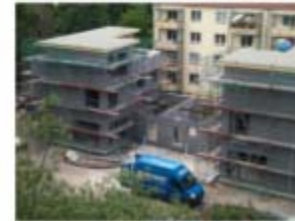
Fenster werden montiert. Elektrik und Sanitärinstallation.
