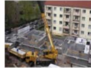
Fertigdecke wird verlegt.
