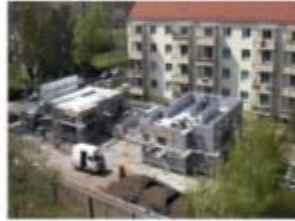
Obergeschoß wird gesteckt.
